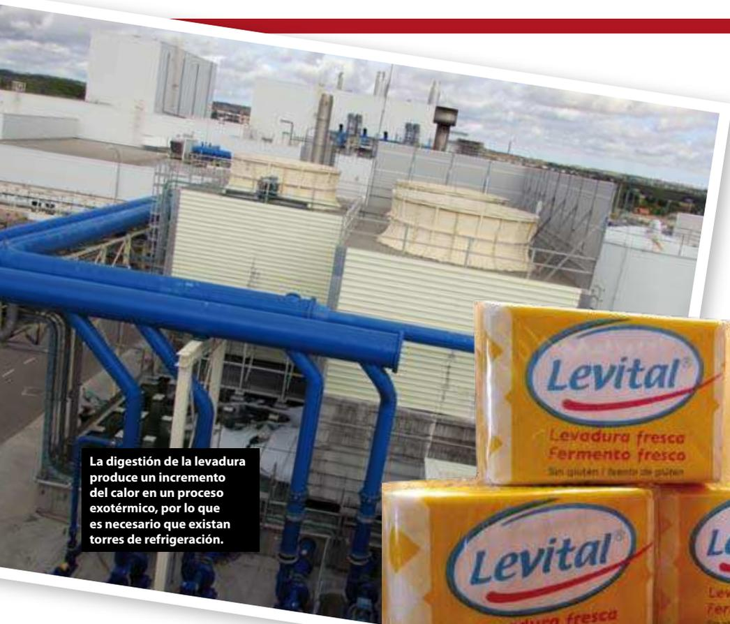
La digestión de la levadura produce un incremento del calor en un proceso exotérmico, por lo que es necesario que existan torres de refrigeración.
